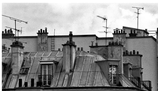
Toit parisien en zinc passivé en surface par des hydroxydes et carbonates
